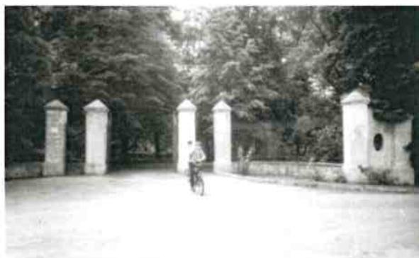
Historyczne zdjęcie bramy wjazdowej
