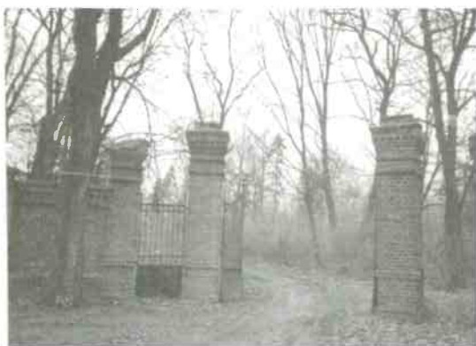
Historyczne zdjęcie bramy wjazdowej
